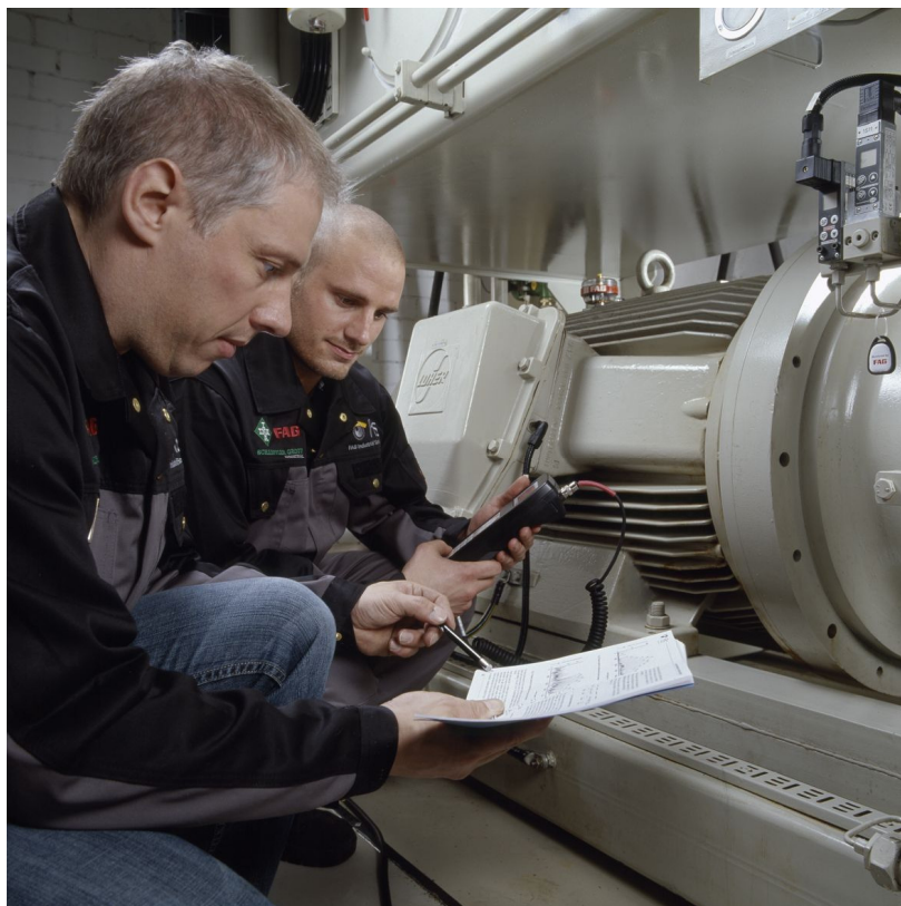
Eindeutige Identifizierung des Messplatzes mittels RFID-Technologie
